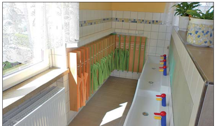
saniertes Waschraum in der 1. Etage
