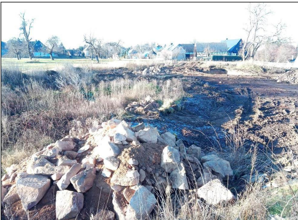
Bild 6: Nach den durchgeführten Abbruchmaßnahmen verbliebene Materialablagerungen innerhalb des Plangebietes (Januar 2020).
