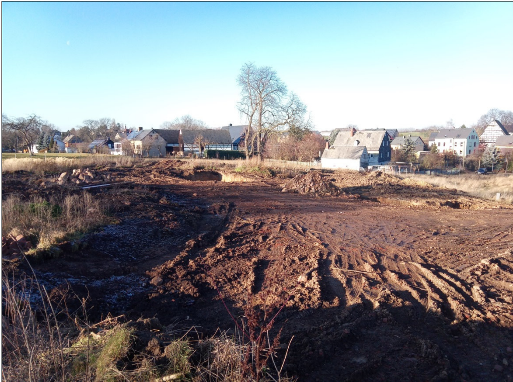
Bild 5: Blick in westlicher Richtung über das zentrale Plangebiet nach den Abbrucharbeiten. (Januar 2020)
