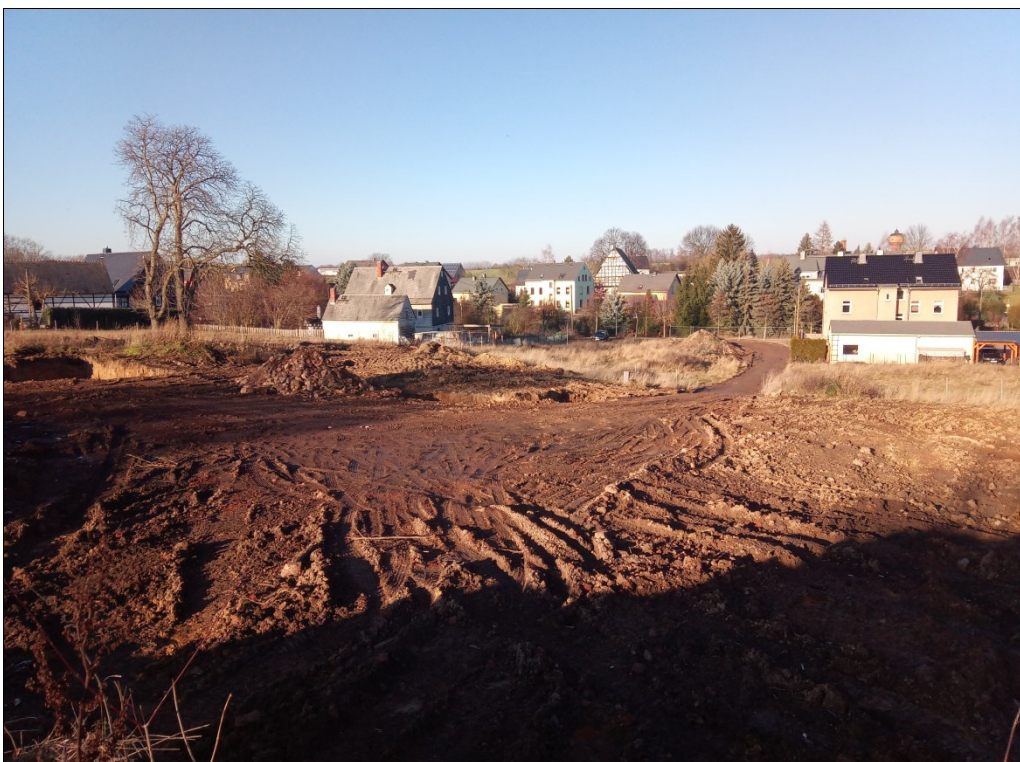
Bild 6: Blick in nördlicher Richtung über das zentrale Plangebiet nach den Abbrucharbeiten. (Januar 2020)
