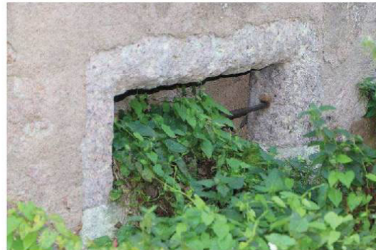
Abb. 13 zu verschließendes Kellerfenster
