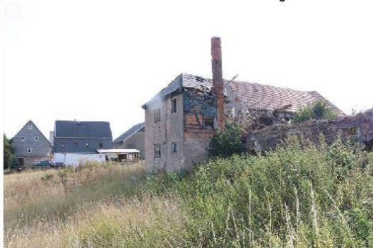
Abb. 12 ehemalige Wandverkleidung am Schornstein
