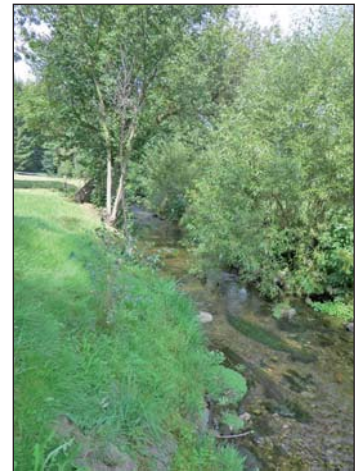
Naturnahe Böschung mit standortgerechter Bepflanzung
