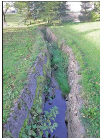
Wo genügend Platz ist, sollten Ufermauern in abgeflachte Böschungen Umgelegt werden.
